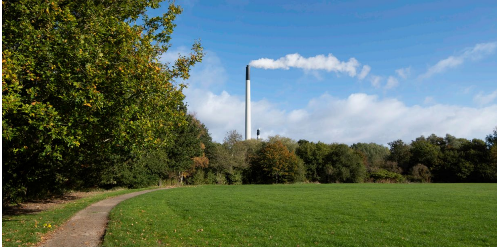
Eksisterende forhold set fra Ejby Mose eng mod sydvest. Her fremstår den eksisterende skorsten som en tydelig visuel markør for Vestforbrænding.
