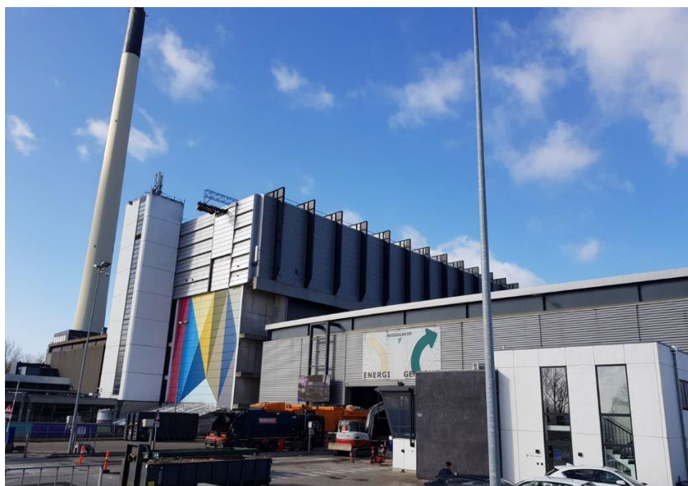
Eksisterende forhold set fra de indre dele af Vestforbrænding. På billedet ses det arkitektoniske udtryk af de nuværende bebyggelser og anlæg.
