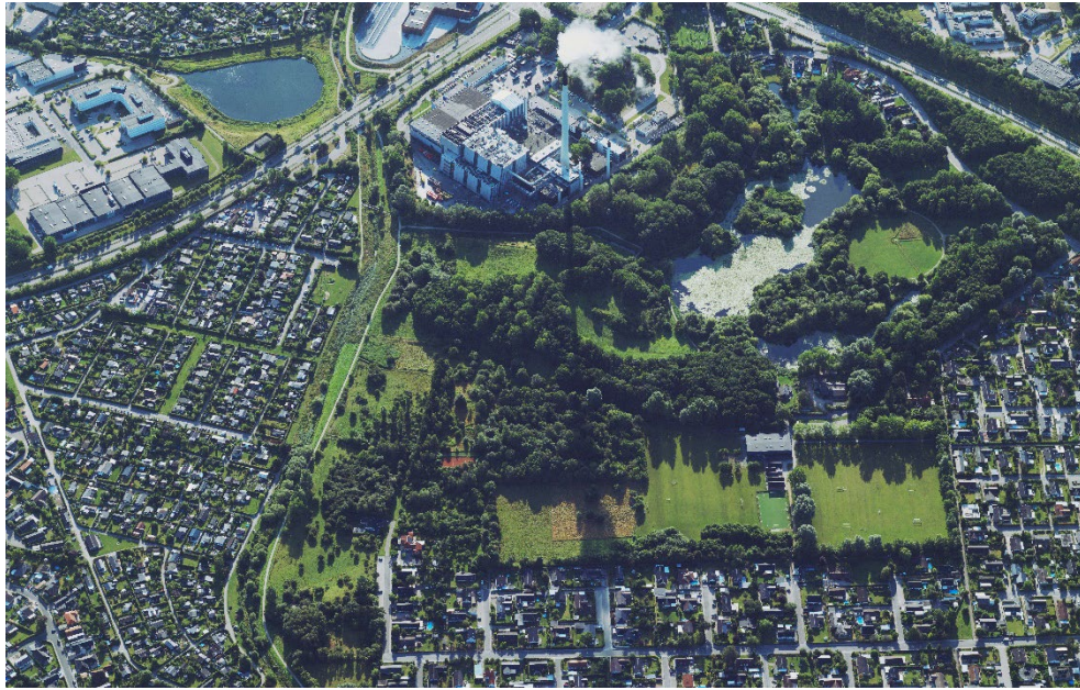
Skråfoto af Vestforbrænding og de rekreative arealer ved Ejby Mose (SDFE).
